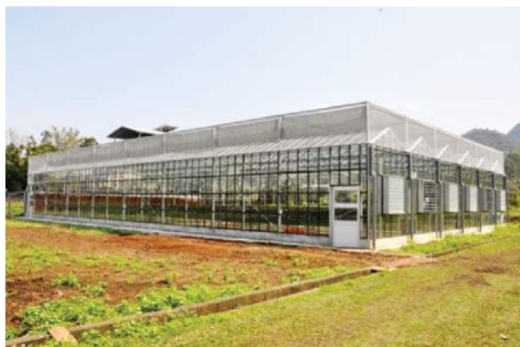
生物防治分場新建精密溫室全貌
