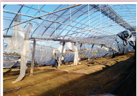
▲ 後龍鎮合興育苗場簡易型設施結構受風災傾倒情形
