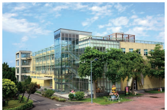
● 環境教育大樓~完工
