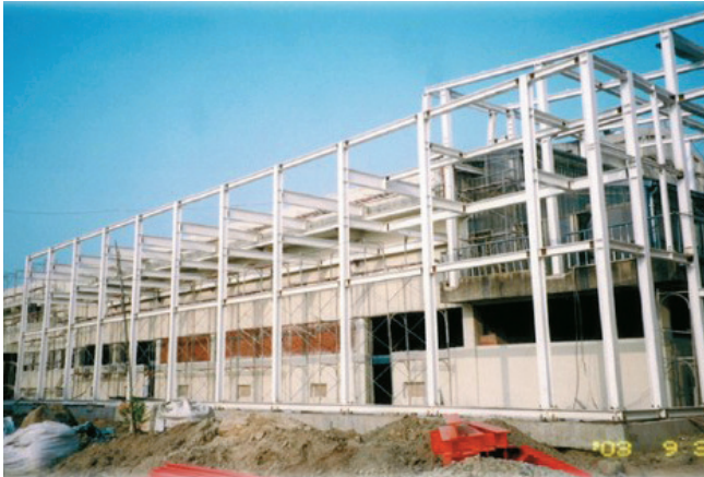
● 生物產業館~施工中
