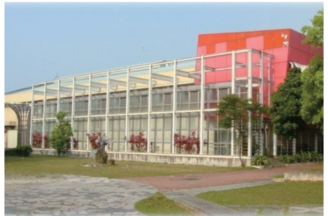
● 生物產業館~完工
